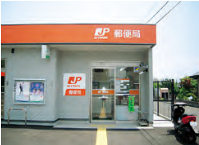
点字ブロック
