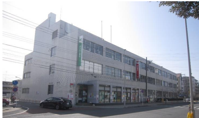
小山郵便局 外観（栃木県）
