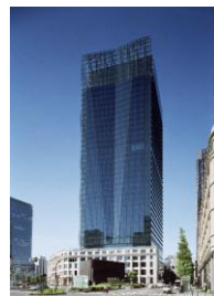
J Pタワー （2012年5月竣工）
