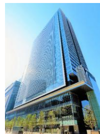
J Pタワー名古屋 （2015年11月竣工）
