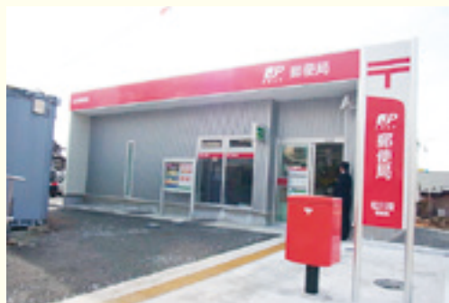
復旧した松川港郵便局（福島県）
