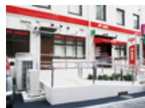
入口スロープ、手すり
