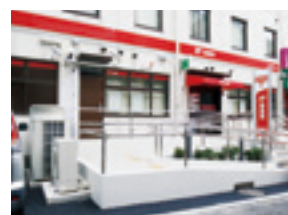
入口スロープ、手すり
