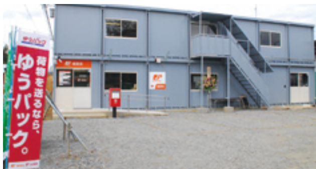
志津川郵便局(宮城県) 仮設店舗
