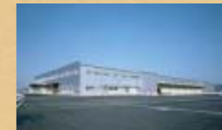
新福岡郵便局(福岡県福岡市) 延床面積:29,344㎡ 構造:鉄骨造・2階建 開局:平成19年3月
