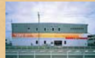
中部国際郵便局(愛知県常滑市) 延床面積:6,978㎡ 構造:鉄骨造・2階建 開局:平成18年6月
