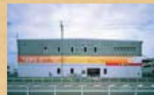
■ 中部国際郵便局(愛知県常滑市) 延床面積: 6,978 m 2 構造: 鉄骨造・2階建 開局: 平成18年6月
