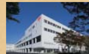
■ 新越谷郵便局(埼玉県越谷市) 延床面積: 20,277 m 2 構造: 鉄骨造・4階建 開局: 平成18年11月
