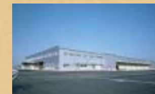
■ 新福岡郵便局(福岡県福岡市) 延床面積: 29,344 m 2 構造: 鉄骨造・2階建 開局: 平成19年3月
