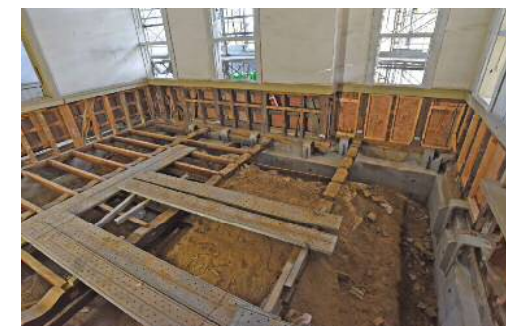
東翼部柱脚金物・構造用合板補強取付・補強基礎打設完了
