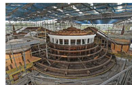
中央ドーム小屋組補修完了
