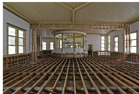
現業室床板解体完了
