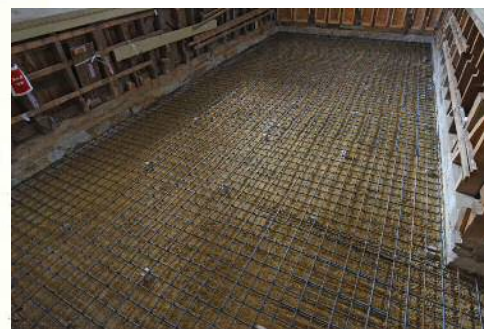
集配人区分室土間コンクリート打設前状況
