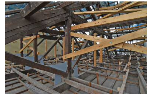
西翼部小屋組(耐震補強後)
