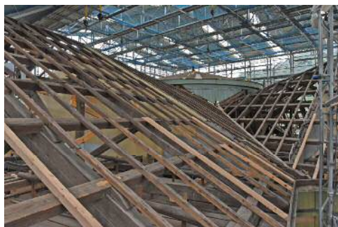
両翼部垂木補修完了
