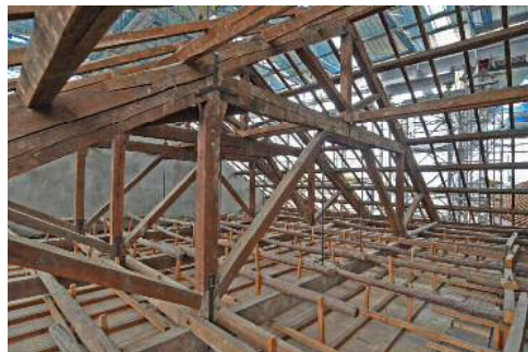
西翼部小屋組(耐震補強前)
